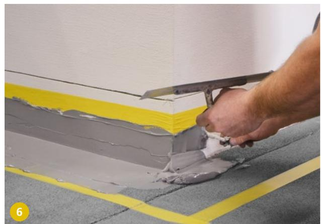
6 Die Schutzbeschichtung erfolgt normalerweise durch den Fassadenbauer und ist auf das Fassadensystem abzustimmen.
