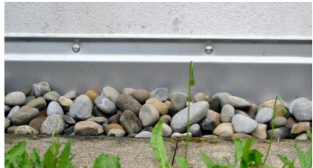
Sockelschutzbleche an bestehenden Fassaden sind unter Berücksichtigung der kapillarunterbrechenden Massnahmen mittels konventionellen Deckstreifen mit Dichtungsfalz auf das Fassadensystem zu montieren.
