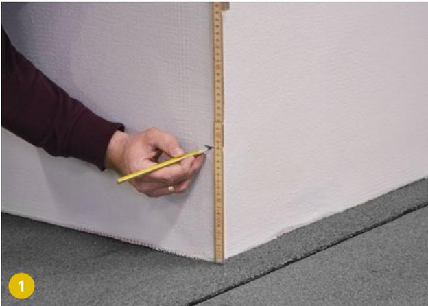
1 Anzeichnen der Stecknut und Kapillarschnitthöhe.
