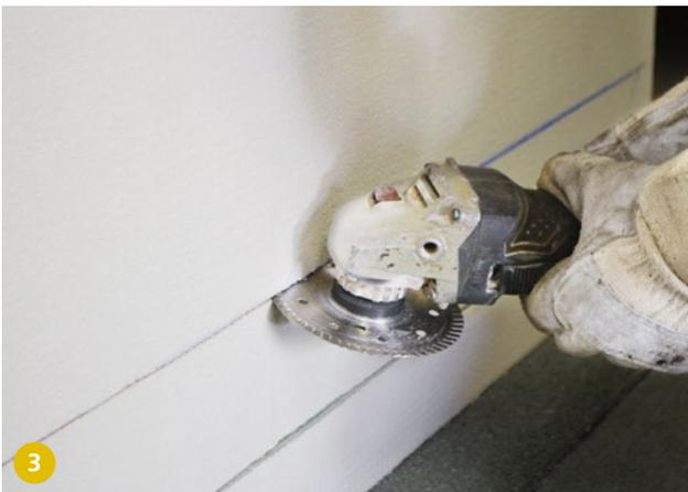
3 Stecknut und Kapillarschnitt mit geeigneten Hilfsmitteln ausführen.
