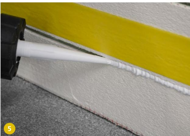
5 Kapillarschnitt mit einem elastischen und feuchtigkeitsschützenden Material verfüllen/versiegeln. Darf aus dem gleichen Material wie die Schutzbeschichtung bestehen.
